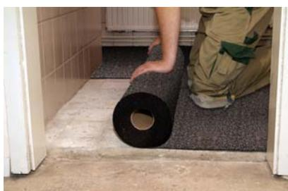
3. Déroulez **DAMTEC® standard** sur toute la surface et découpez-la dans des dimensions plus larges. Laissez **DAMTEC® standard** se détendre et s'acclimater pendant 24 heures au minimum.
