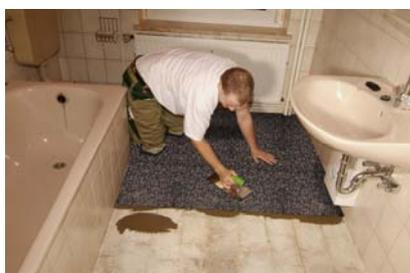
6. Placez **DAMTEC® standard** avec la surface sur la colle, en évitant le plissement, et marouflez soigneusement. En suite effectuez le collage de l'autre moitié de la surface de la même façon.
