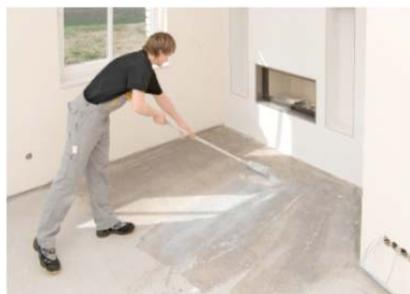
1. Balayer ou passer l'aspirateur sur la surface du support. Pour aplanir des bosses et des inégalités, d'abord traiter la surface avec des précouches ou des couches de fond appropriées, et puis niveler avec une bouchepores.
