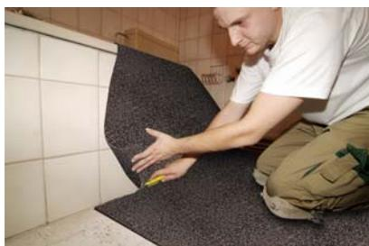
4. Découpez la sous-couche **DAMTEC® standard** dans les dimensions exactes.
